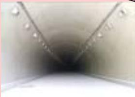
下三永トンネルの照明器具が取り付けられました。後は電気を接続すれば完成です。
