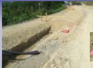
通信ケーブルなどを入れる通信管(写真では黒色の管)を土中に埋めています。管の上には、将来掘り起こす際に管が埋まっていることがわかるように「この下に通信ケーブルあり」と書かれたピンクのシートも一緒に埋められます。
