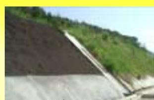
法面に種と土と肥料と接着材を混ぜたものをホースで吹き付けます。(写真左側の黒い部分) 写真右側は吹きつけ後、1年半経過した様子です。
