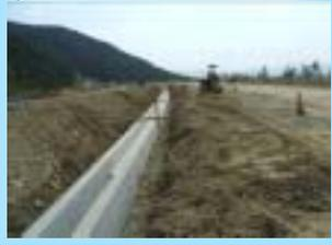
側溝の設置をしています。
