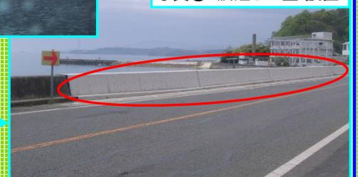
写真②:波返しの壁設置
