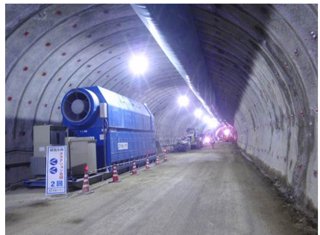
写真-4 工事中のトンネル内(H25.12)
