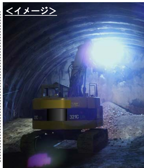
東広島・呉道路金剛山トンネル 貫通の瞬間(2013/7/31)
