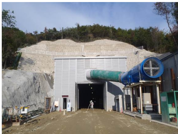
写真-3 トンネル坑口(H25.12)
