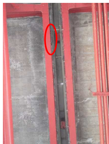
橋梁床版下面状況
