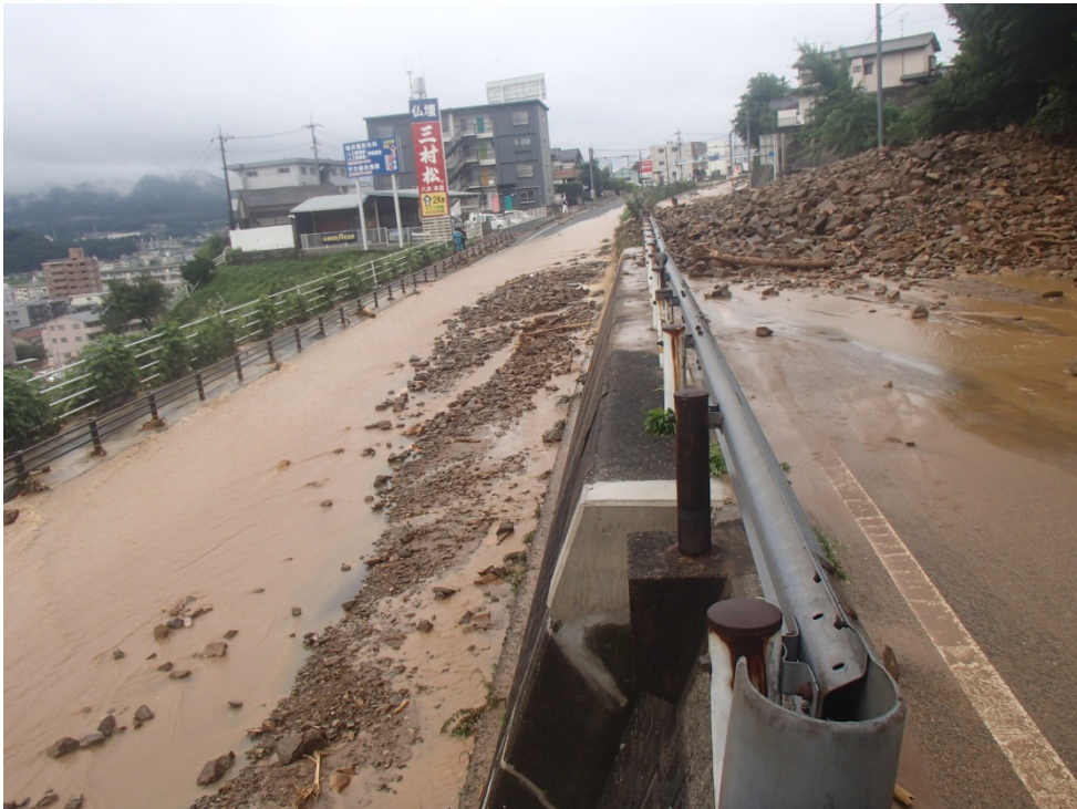
災害発生状況
