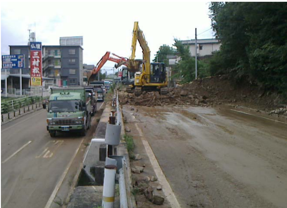
土砂の撤去状況
