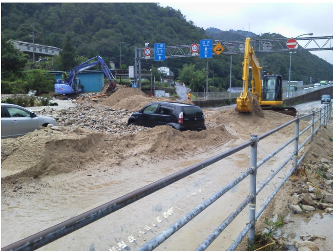
土砂の撤去状況
