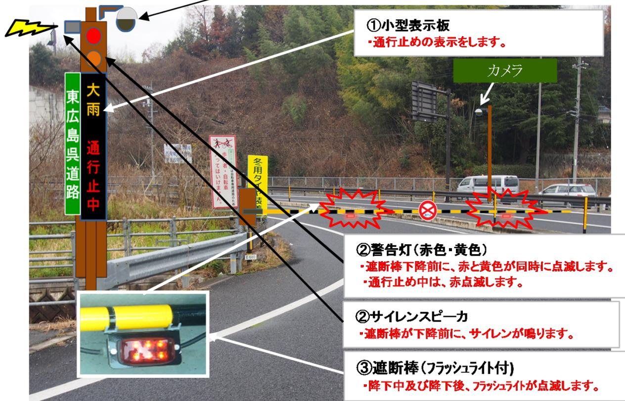
⚠ 次の様な場合に、交通遮断機の遠隔操作により通行止めを行います。
