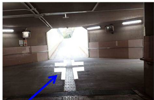
※地下道内の交差部に交差する状況を示す路面表示を設置します。
