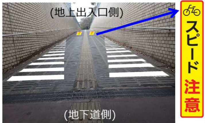
※自転車への注意喚起と速度抑制を促す路面表示を設置します。
