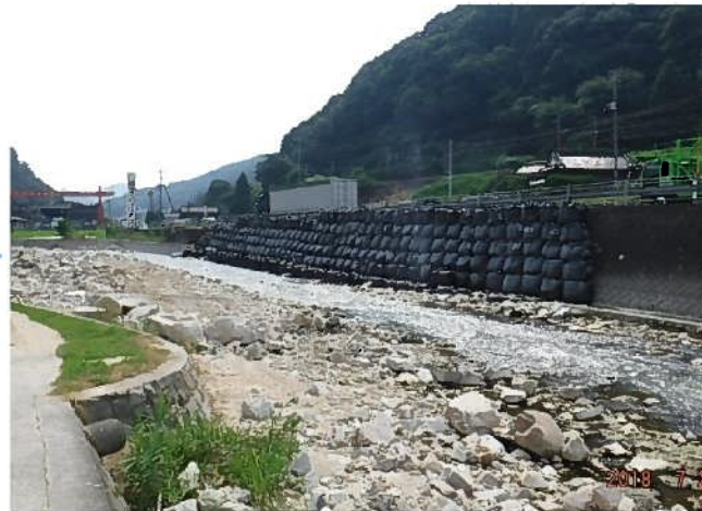
応急復旧状況(H30.7下旬)
