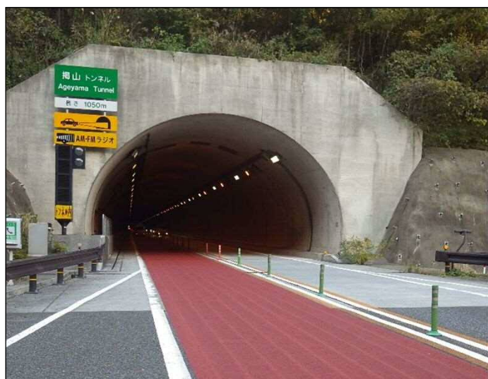
写真① 施工後
