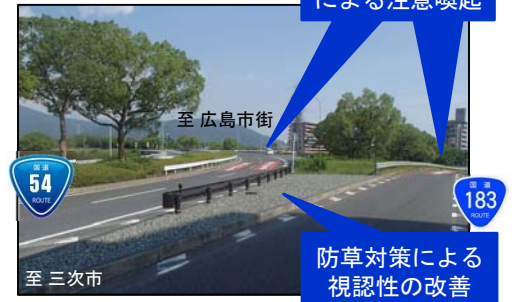
■対策後の状況
