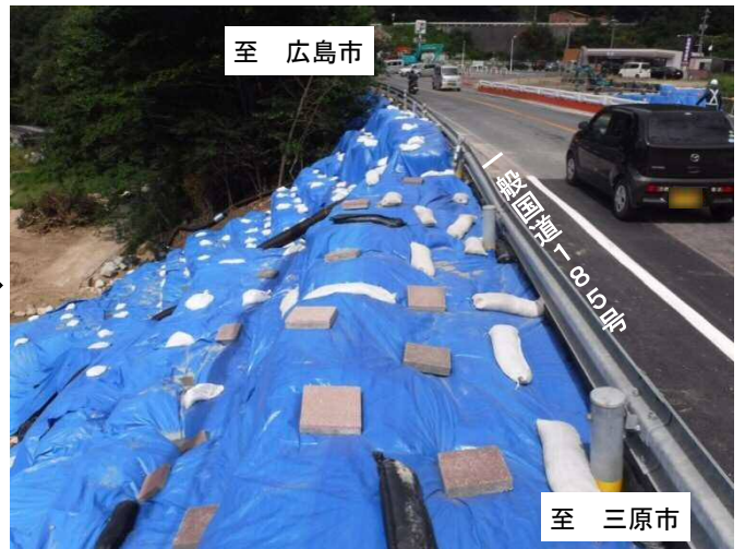
応急復旧の状況（平成30年9月23日）
