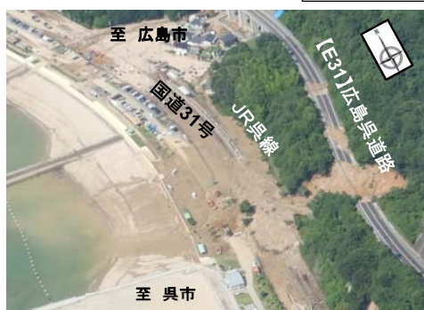
国道31号被災状況
