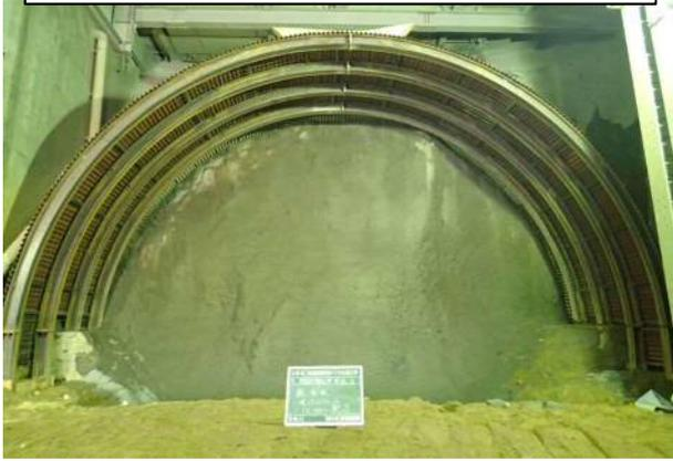
覆工コンクリート用の型枠を設置
