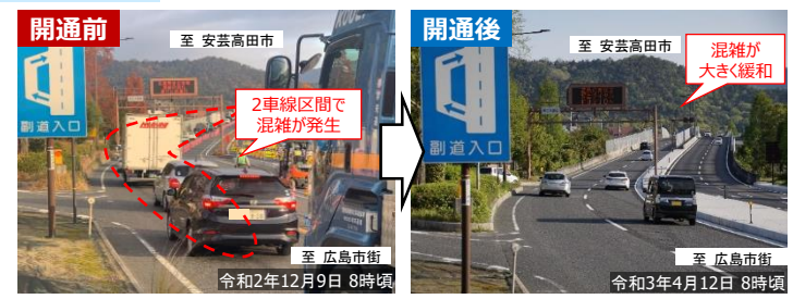
【写真①】可部取水場(東)交差点付近
