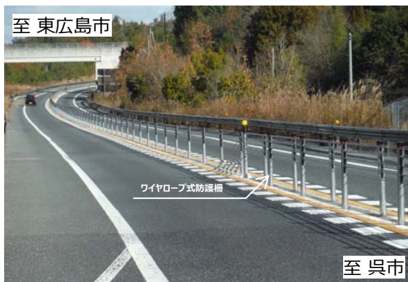
【E75】東広島・呉自動車道(馬木IC～高屋JCT・IC間)
