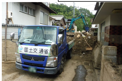
平成30年7月31日 道路啓開作業(広島県安芸郡坂町)
