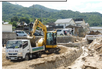
平成30年7月31日 土砂撤去作業(広島県安芸郡坂町)
