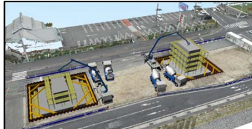
③橋脚躯体施工 (鉄筋・型枠・コンクリート)
