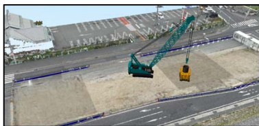
①場所打杭施工
