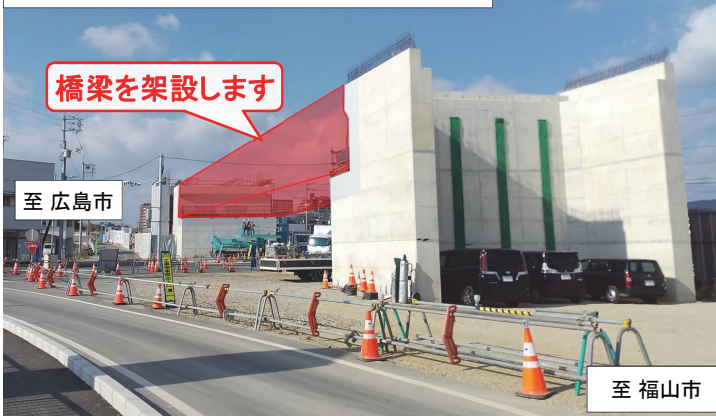
工事進捗中の道照交差点(R6.1.12撮影)
