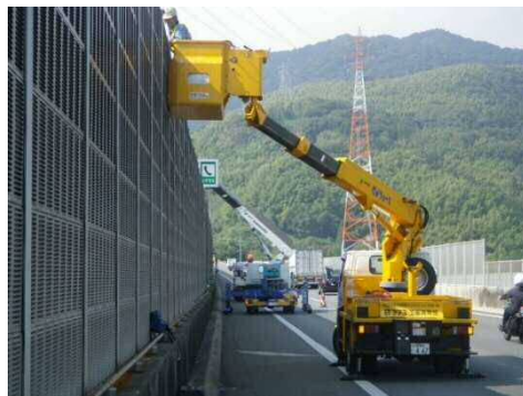
《落下物防護柵設置作業イメージ》
