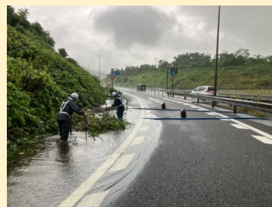
道路冠水箇所の排水作業 (東広島市：東広島呉道路)
