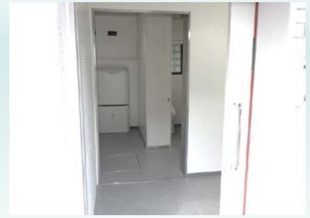
LEDライトで明るく 広いトイレ室内へ変更
