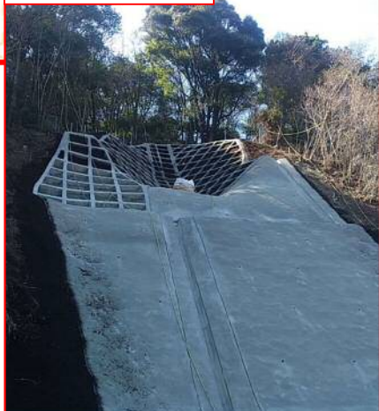
対策完了箇所③
