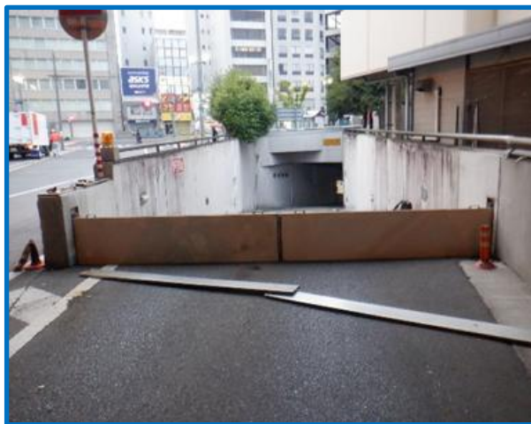
参考: 紙屋町地下駐車場出口に止水板を設置した状況
