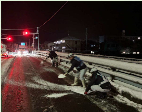
凍結防止剤散布 (国道2号)
