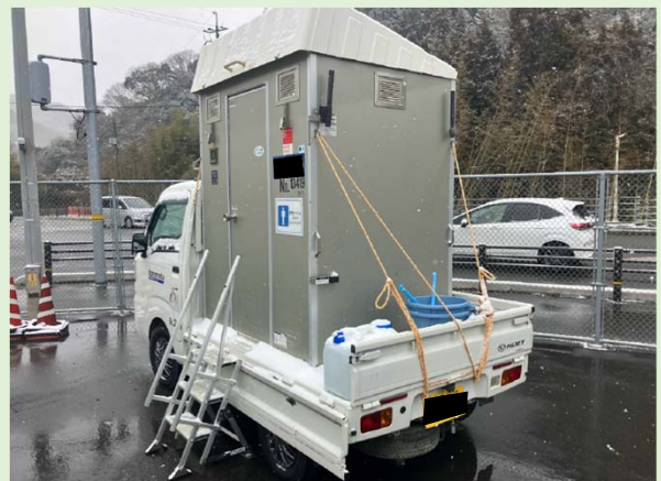
トイレカー設置 (国道2号)
