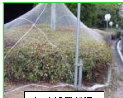
ネット設置状況
