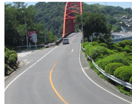
▲バイパス開通後の音戸大橋の状況 (平成25年7月 13時頃撮影)
