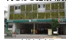
吉祥寺商店街 共同集配送センター （東京都武蔵野市）
