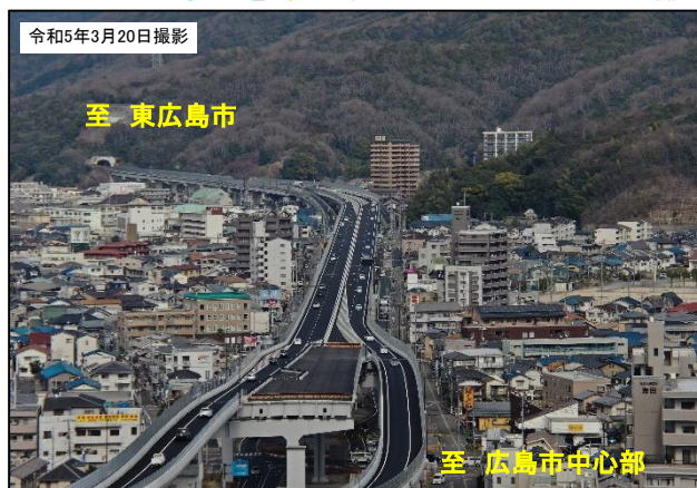
【写真①】海田高架橋付近 開通状況
