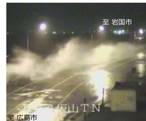
【写真③】越波の状況(H17.9)
