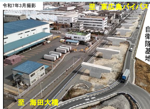
【写真②】明神地区施工状況
