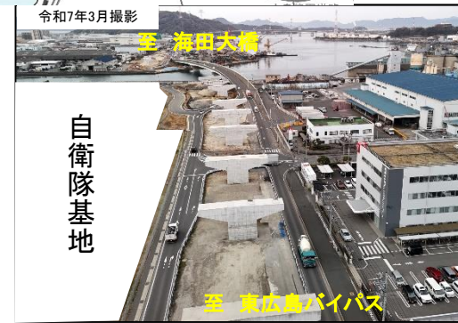
【写真③】明神地区施工状況
