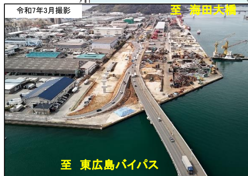
【写真①】明神地区施工状況
