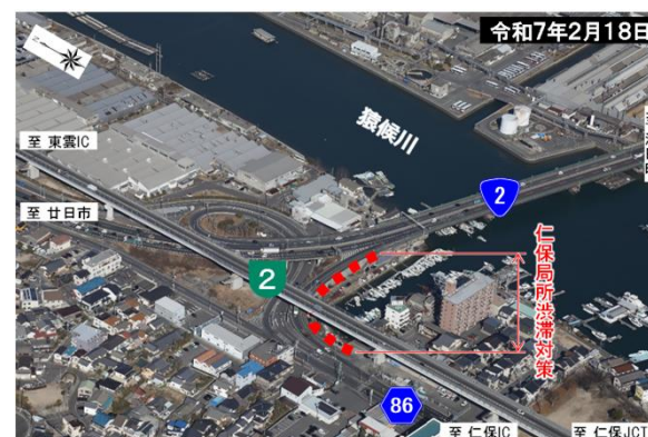
【写真②】仁保局所渋滞対策の周辺状況
