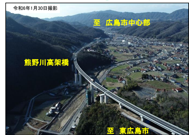
【写真③】熊野川高架橋付近 開通状況
