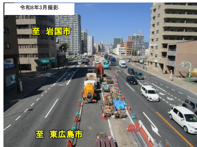
【写真②】都心部延伸事業の施工状況
