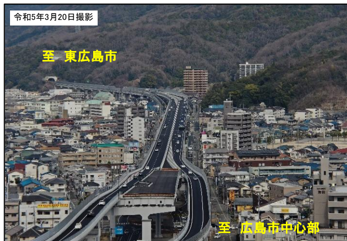
【写真①】海田高架橋付近 開通状況
