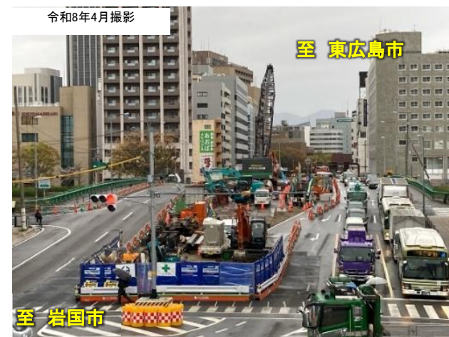
【写真①】都心部延伸事業の施工状況
