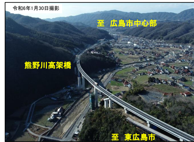
【写真③】熊野川高架橋付近 開通状況
