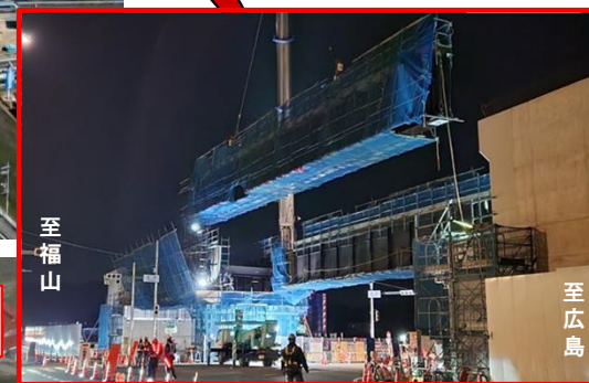
(R6.2.2 上部工架設工事)
