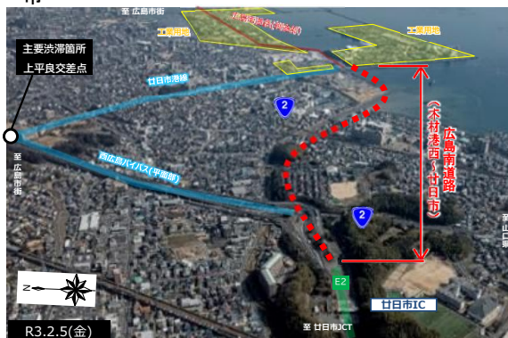
【写真①】広島南道路(木材港西～廿日市)の周辺状況
