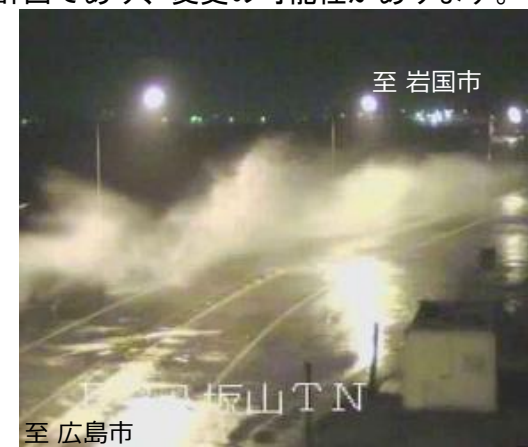
【写真③】越波の状況(H17.9)
