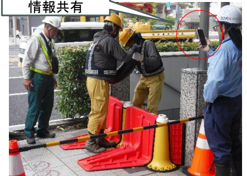
車両用出口および歩行者用出入口にて、止水板を正常に設置できるか確認
