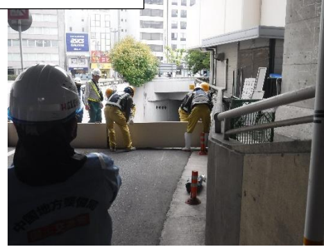
車両用出口および歩行者用出入口にて、止水板を正常に設置できるか確認
