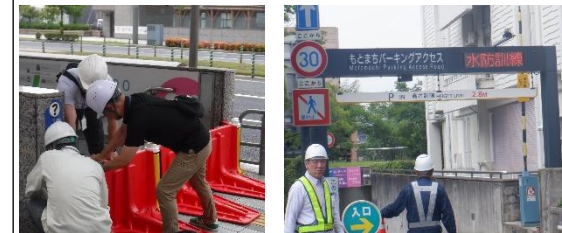
広島地下街開発(広島市)による地下出入口閉鎖訓練
