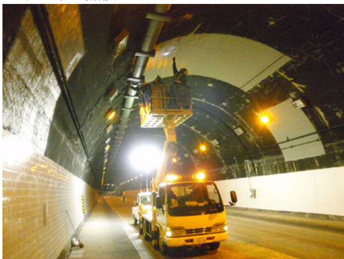
高所作業車による点検 本体工
