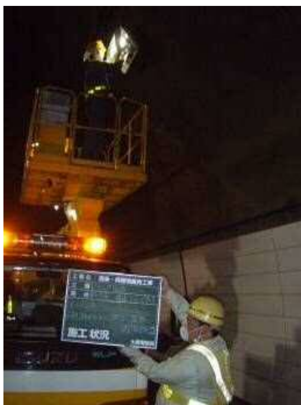
トンネル照明灯のランプ球替え
