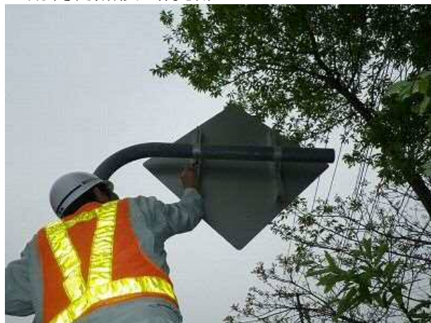
○ 附属物点検（標識）
