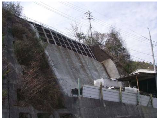
対策後(法枠工)
