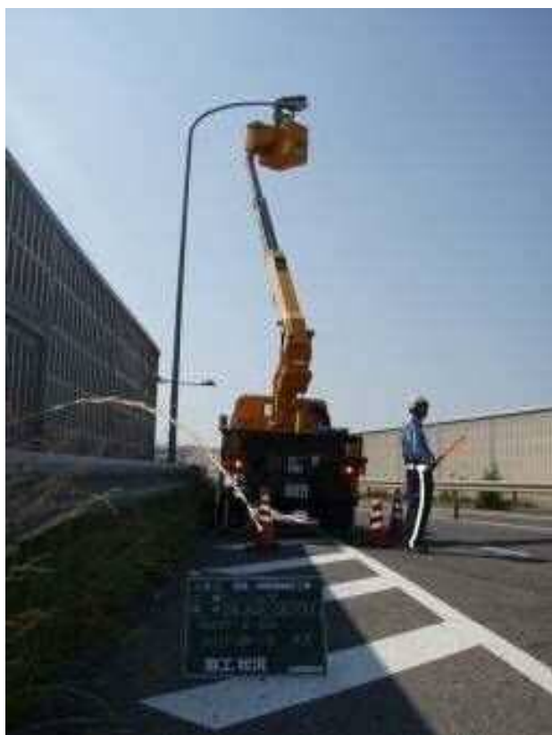
道路照明灯のランプ球替え
