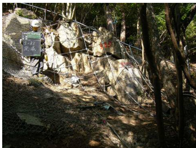
対策後(ロープネット工)
