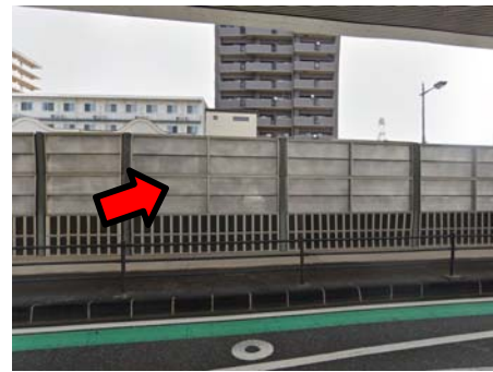
中央分離帯遮音壁 (高さ約3m)
