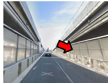
高架部遮音壁(ランプ部) (高さ約2m)
