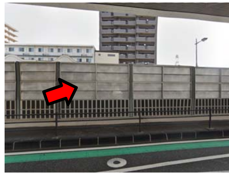
中央分離帯遮音壁 (高さ約3m)
