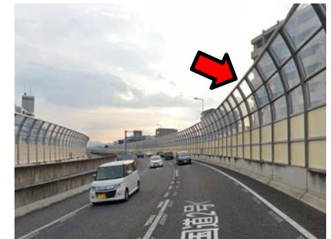
高架部遮音壁(本線部) (高さ約5m)
