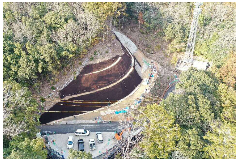
【法面工 施工状況】
