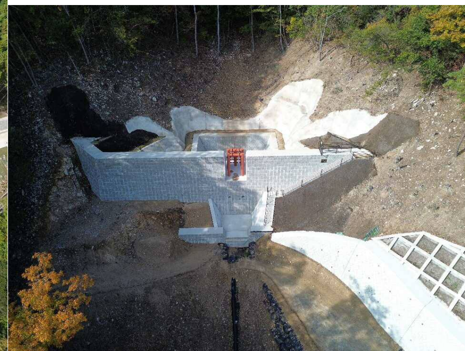
【九品寺 2 号砂防堰堤】
