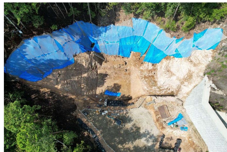
【九品寺 3 号砂防堰堤 掘削完了】
