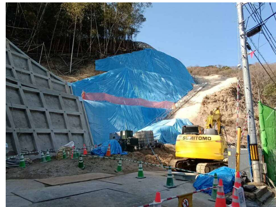
【管理用道路 施工状況】
