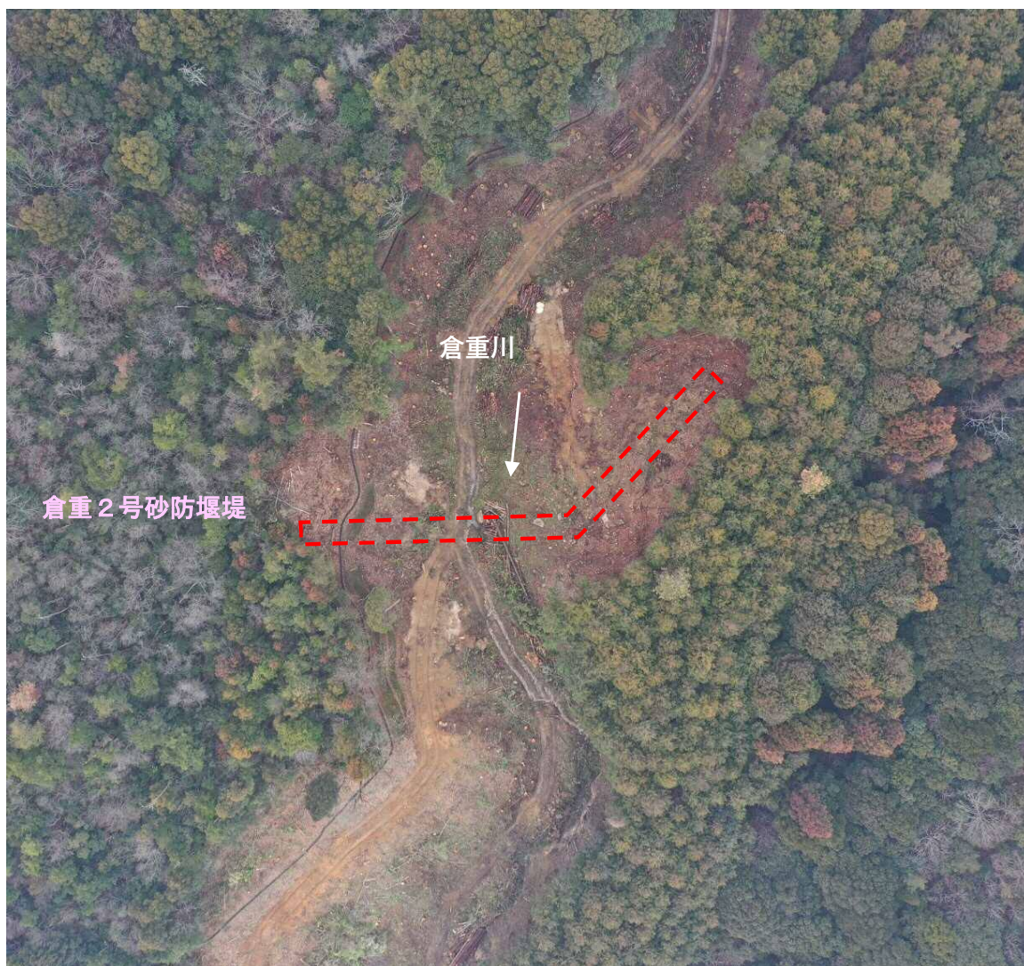
【全景 堰堤真上から】
