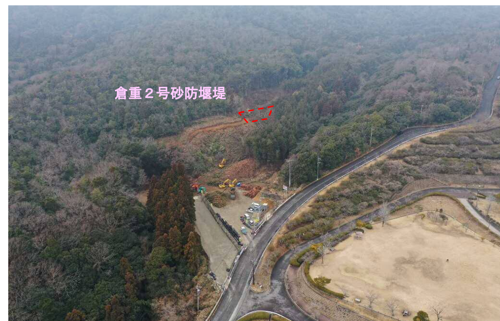
【全景 堰堤下流から】
