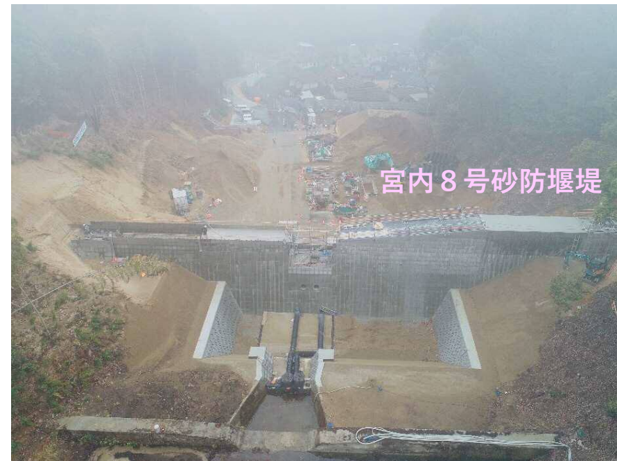
【施工状況（上流より）】
