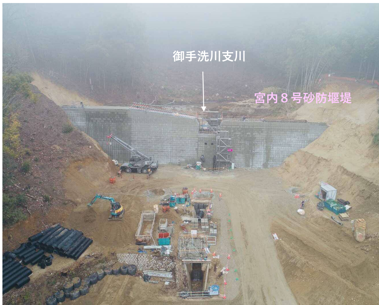
【施工状況（下流より）】
