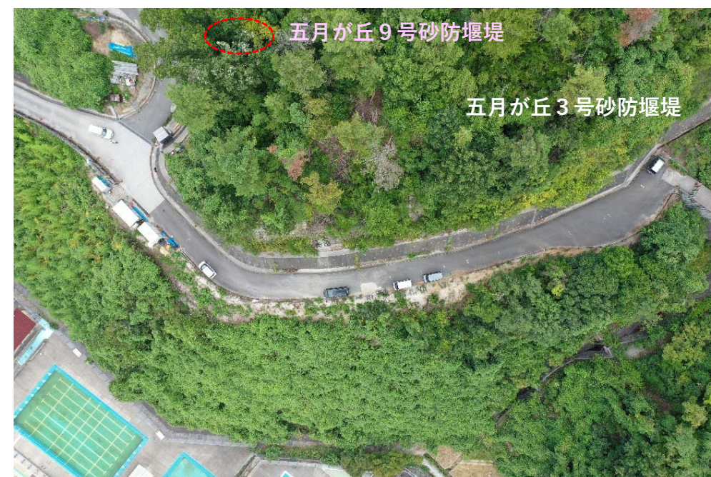
【五月が丘9号砂防堰堤 施工状況】
