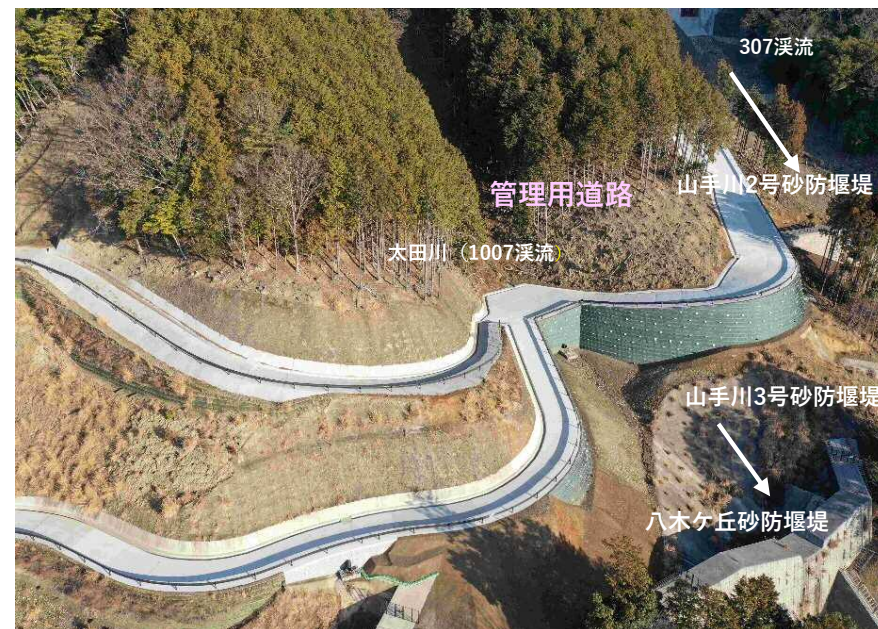
【施工状況（全景）】
