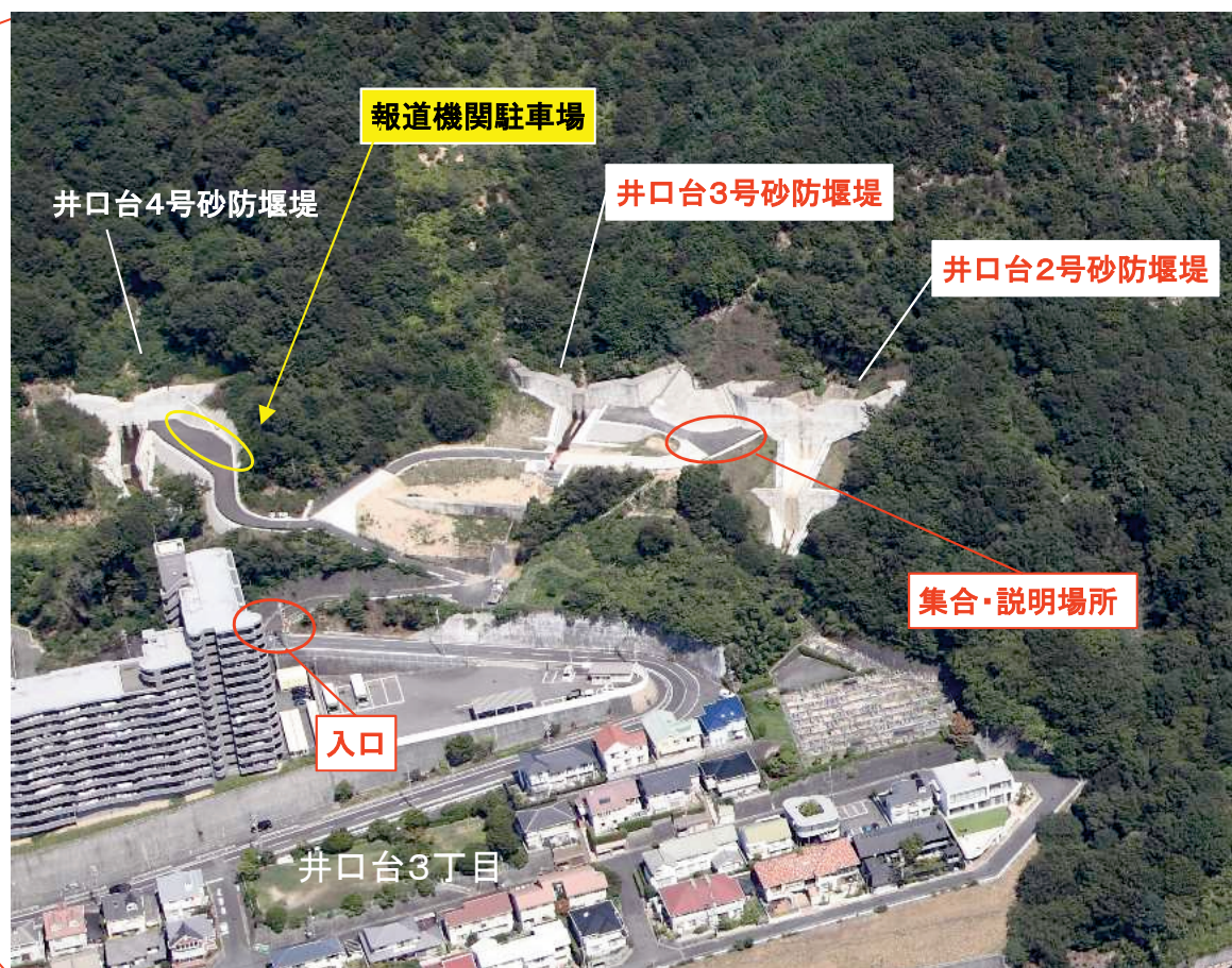
訓練実施場所：広島市西区井口台3丁目（井口台2号・3号砂防堰堤）
