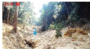
土石流警報装置設置状況
