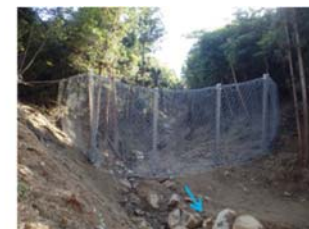
強靱ワイヤーネット設置状況
