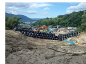
導流工実施状況
