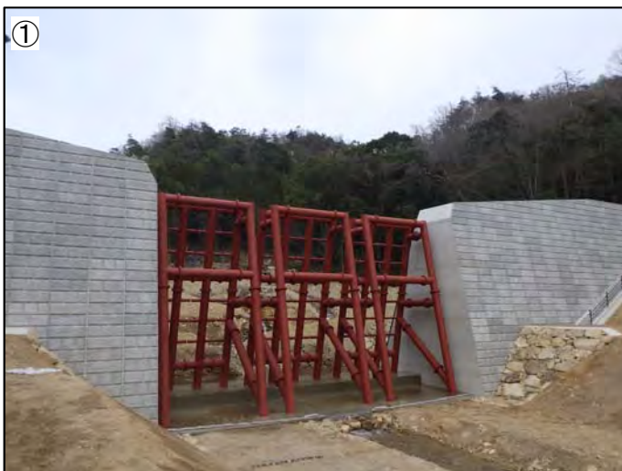
堰堤整備状況 (2-2-74溪流)
