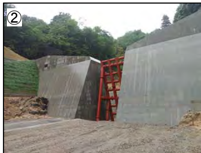
堰堤整備状況 (1-9-279-2隣溪流)
