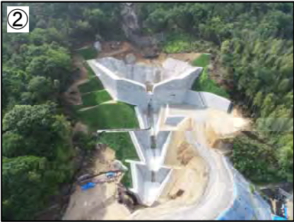
前庭保護工施工状況 (3-91-92隣e溪流)
