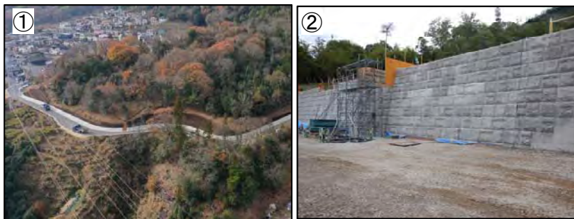
① 進入路施工状況（全景） （1-9-486溪流）
