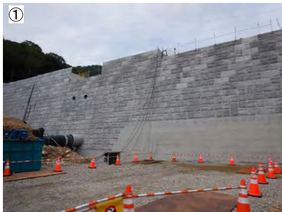
① コンクリート打設 （嵩上げ）状況 （1-9-226渓流）
