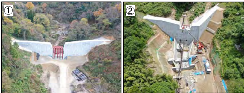
堰堤整備状況 (2-24-7溪流)
