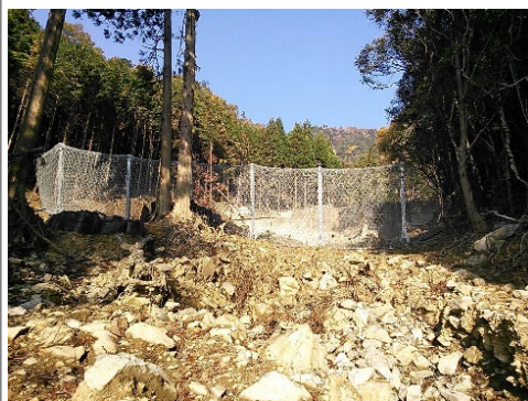
ワイヤーネット 設置事例
