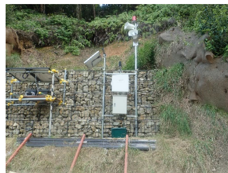
土石流警報装置設置状況
