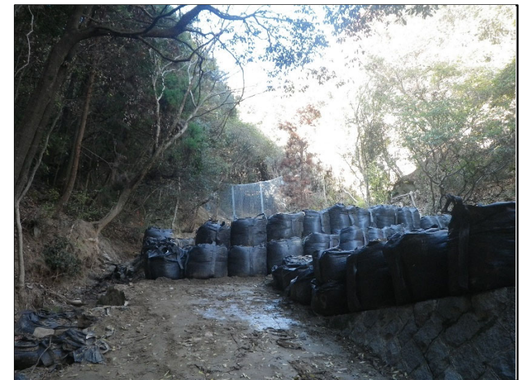
流路工設置状況
