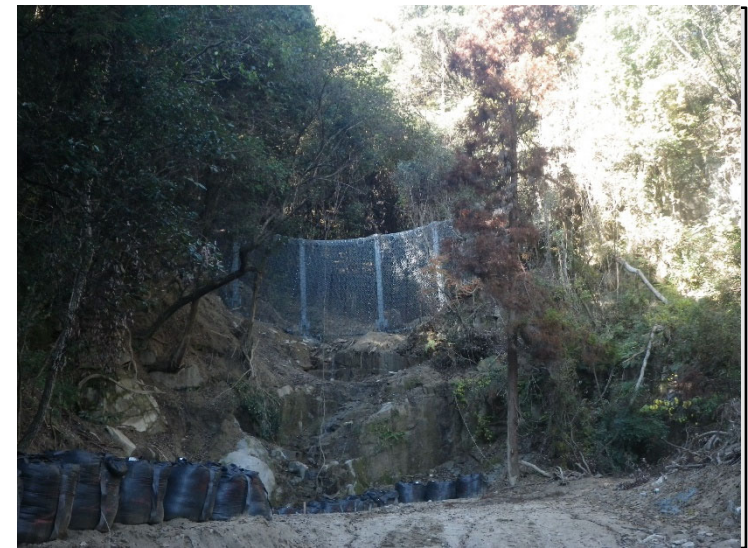
強靱ワイヤーネット設置状況
