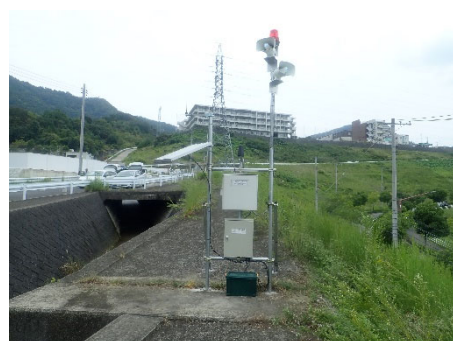
土石流警報装置設置状況
