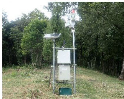
土石流警報装置設置状況
