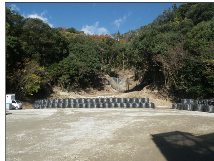
流路工設置状況
