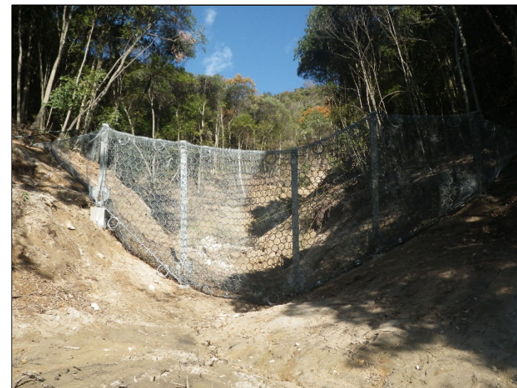
強靱ワイヤーネット設置状況
