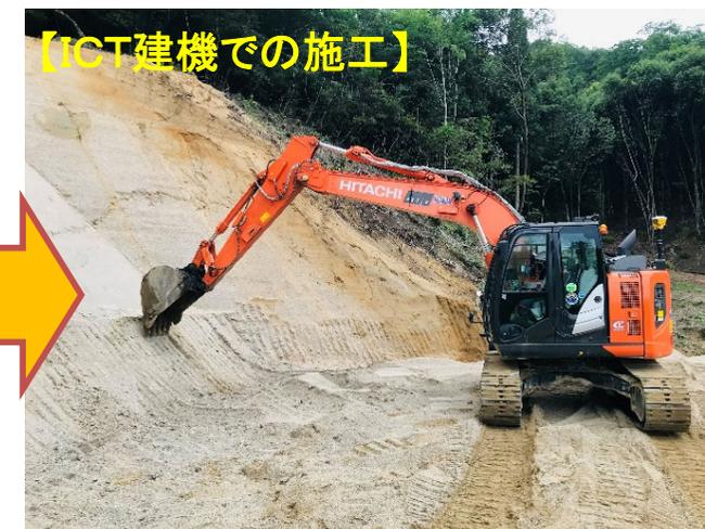
設計データどおりに施工できるので、施工精度が向上し、作業時間も短くなります。
